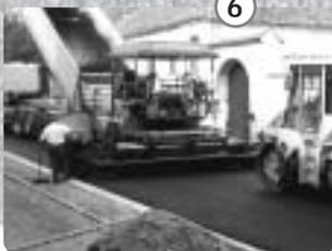
Beim Straßenbau wird der Splitt als oberste Schicht in das Asphaltgemisch gestreut. Der eingearbeitete Splitt verhindert, dass die Autoreifen am Asphalt rutschen.
